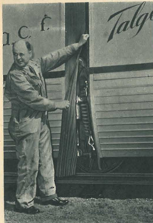
I mantici fra le unità del treno vengono assicurati mediante chiusure lampo interne ed esterne.
